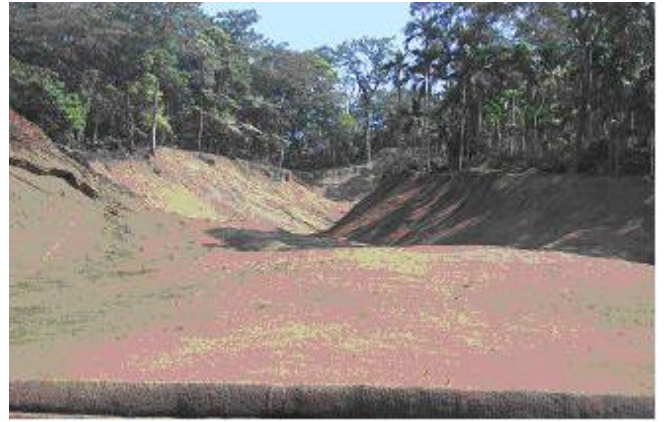
完工後植生情形 91.12
