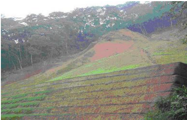
完工後植生情形 92.01
