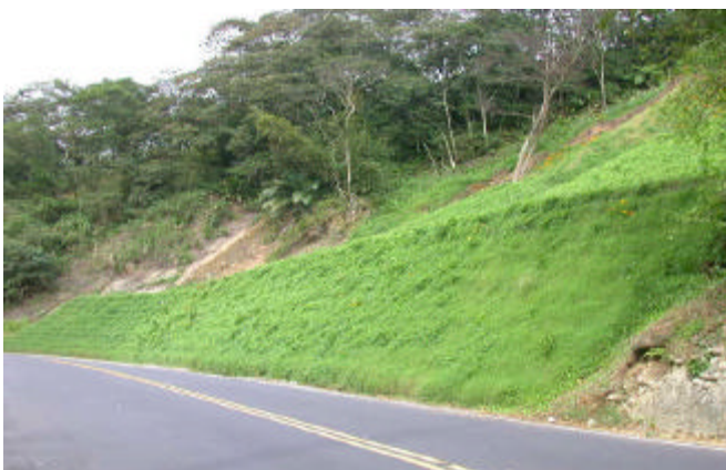
完工後植生情形 92.05
