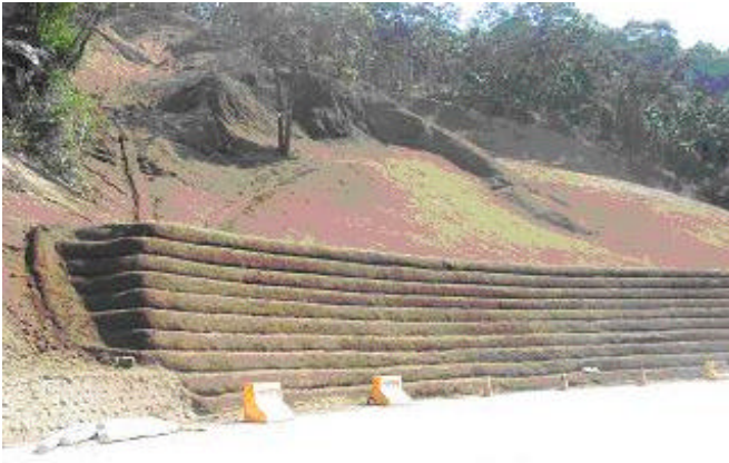
完工後植生情形 91.12
