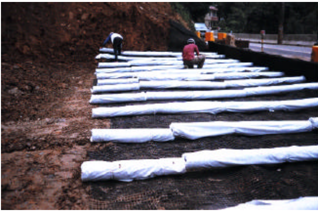
圓型式排水速排龍鋪設
