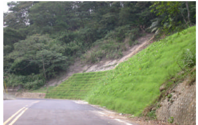
完工後植生情形 92.05
